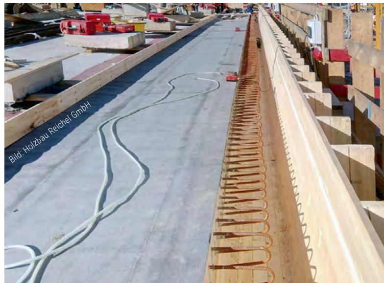
► Brückenbau: Kappenschalung an der Bundesautobahn A3
