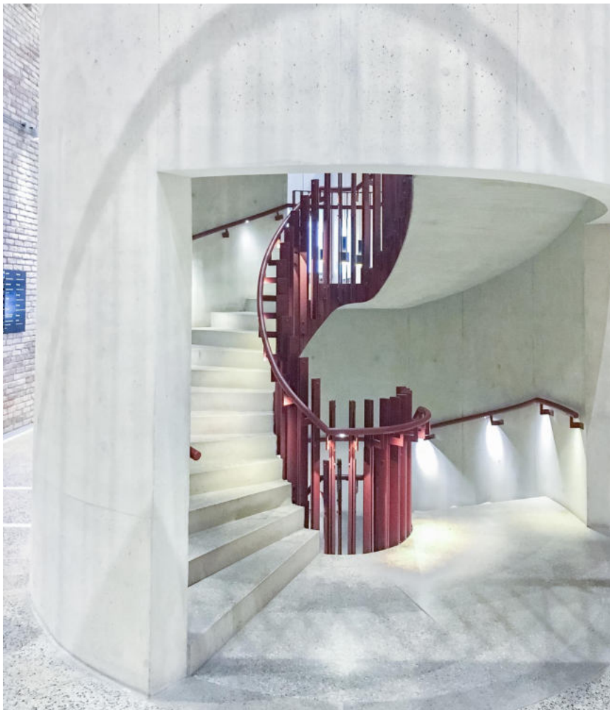
► Bei Balkon- und Treppenschalungen wie bei dieser Betontreppe kommt es auch auf Oberflächenqualitäten an.
