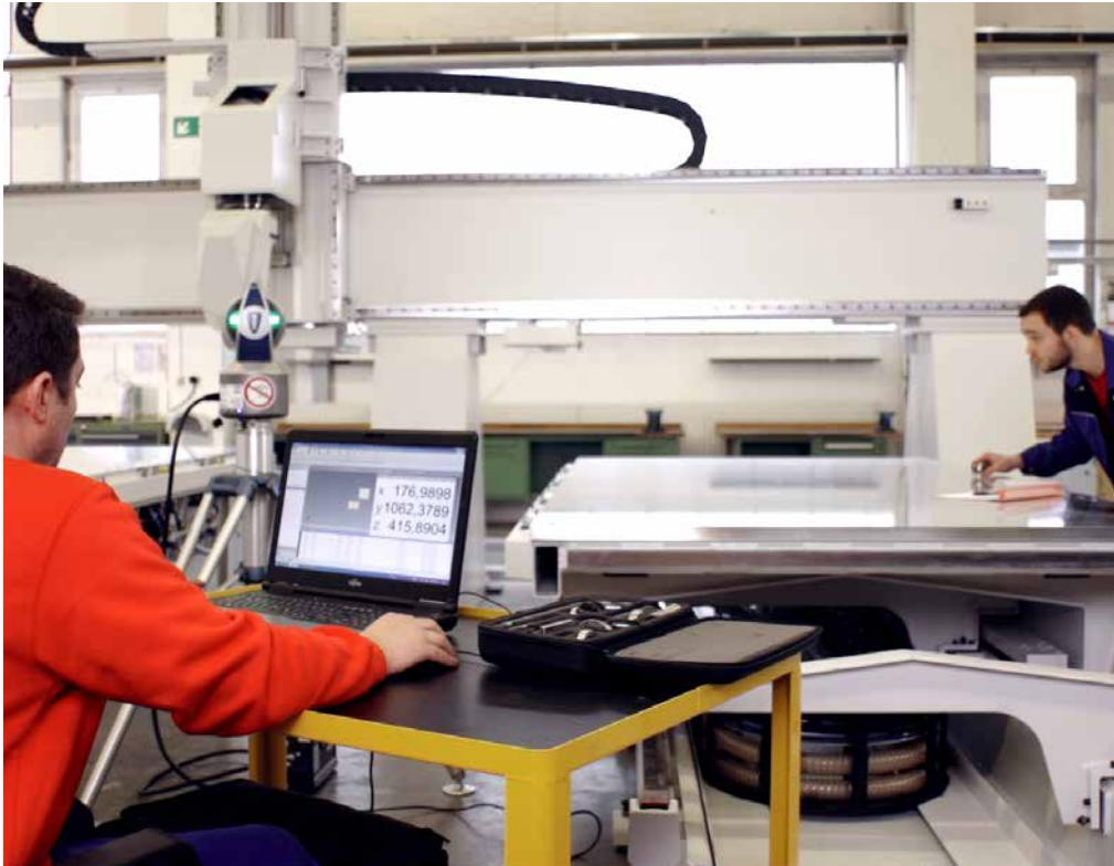
Eine Reichenbacher Hamuel Portalfräsmaschine Typ ECO mit zwei Tischen wird gerade nivelliert und dreidimensional im Raum ausgerichtet.
