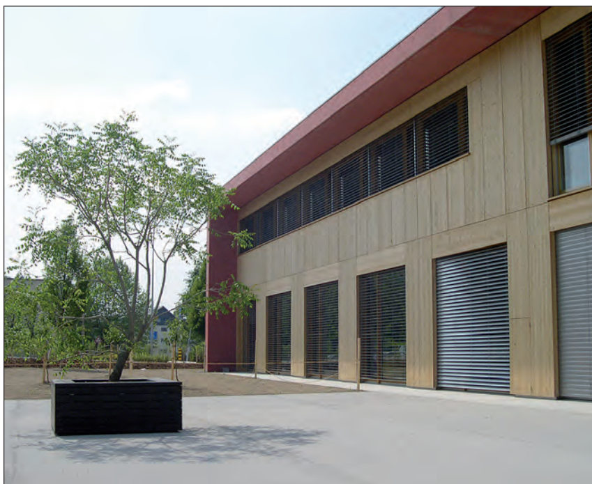
Fassade des Schulhauses in Rotkreuz – mit Holz gestaltet
