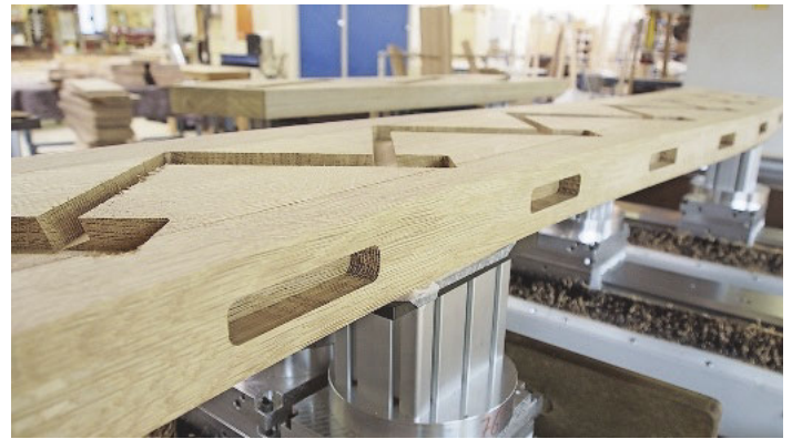
/ Ausgefeilte Bearbeitung: Wortmann fräst Brettstäbe nicht im extrem spitzen Winkel in die Wangen, sondern senkrecht. Die Stäbe werden dann abgestirnt.
